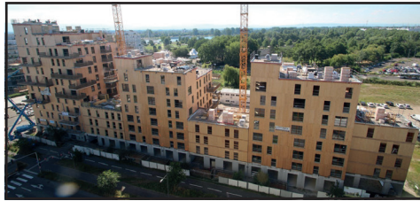
Structure achevée à Strasbourg ©Eiffage construction
