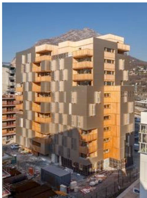
Le Solaris, 38 Sozialwohnungen in Grenoble, präsentiert auf dem Forum Holzbau in Nancy am Donnerstag, 6. April um 14.30 Uhr von Pierre Payrad, Jean-Pul Roda und Thomas Charlier im Atelier A2, Mischbauten – Umgang mit Schnittstellen. Foto: Pierre Payrad
