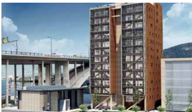
Das 14-geschossige Wohnhaus namens «Treet» in Bergen/ Norwegen besteht aus gestapelten Holzmodulen, die eine Fachwerkkonstruktion trägt. Es soll im Herbst 2015 fertiggestellt sein.
