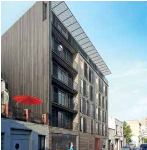
Das neue, passivhaus-OSICA-zertifizierte sechsgeschossige Mehrfamilienhaus in Montreuil ist eines der Vorzeigebauwerke des mehrgeschossigen Holzbaus in Frankreich.
