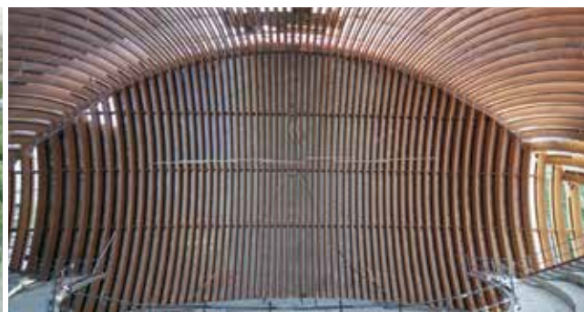
Eng aneinandergereihte Brettschichtholz-Bogenbinder bilden den Raum der neuen Kathedrale «Notre-Dame» in Créteil. Von aussen erinnert sie an eine stehende Muschel.
