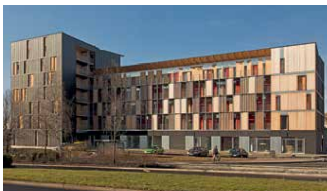
Sozialer Wohnbau in Frankreich: Der neue, L-förmig angelegte Gebäudekomplex in Aurillac mit 42 Wohnungen. im Bild zu sehen ist die aufgelöste Nord-Ost-Fassade des Holzbaus mit Holzfassade.
