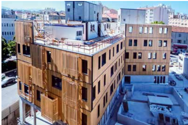
Der neue, siebengeschossige Bürobau „Les Docks Libres“ in Marseille während der Bauphase. Sein Energiestandard soll 20 Prozent besser sein als die französische EnEV «RT 2012» fordert. Das Gebäude entspricht zudem der Norm «Nachhaltiges Bauen im Mittelmeerraum».
