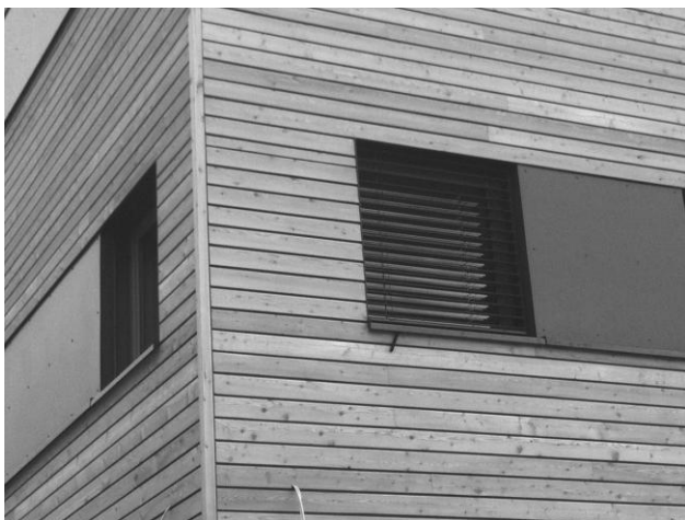
Abbildung 13: Raffstore-Anlage
