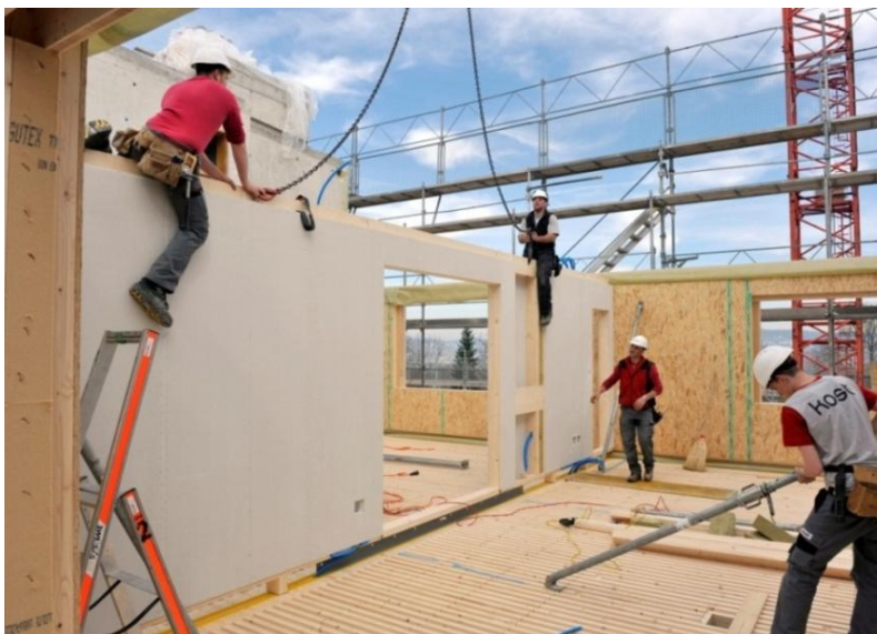
Holzbauer beim Aufrichten einer tragenden Innenwand
