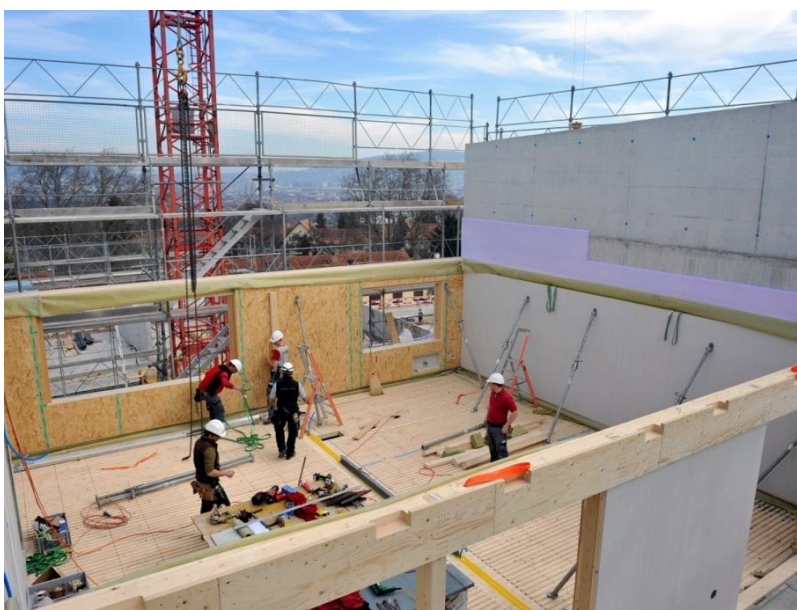
Holzbauer beim Aufrichten einer tragenden Innenwand
