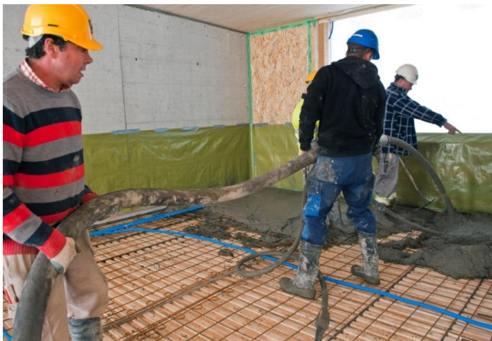
HBV-Decke vor dem Aufbringen des Überbetons
