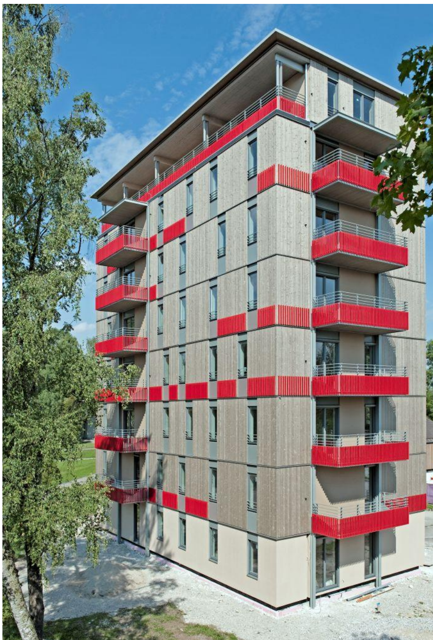
Abbildung 2: Ansicht Südwest Holz 8 © Huber & Sohn
