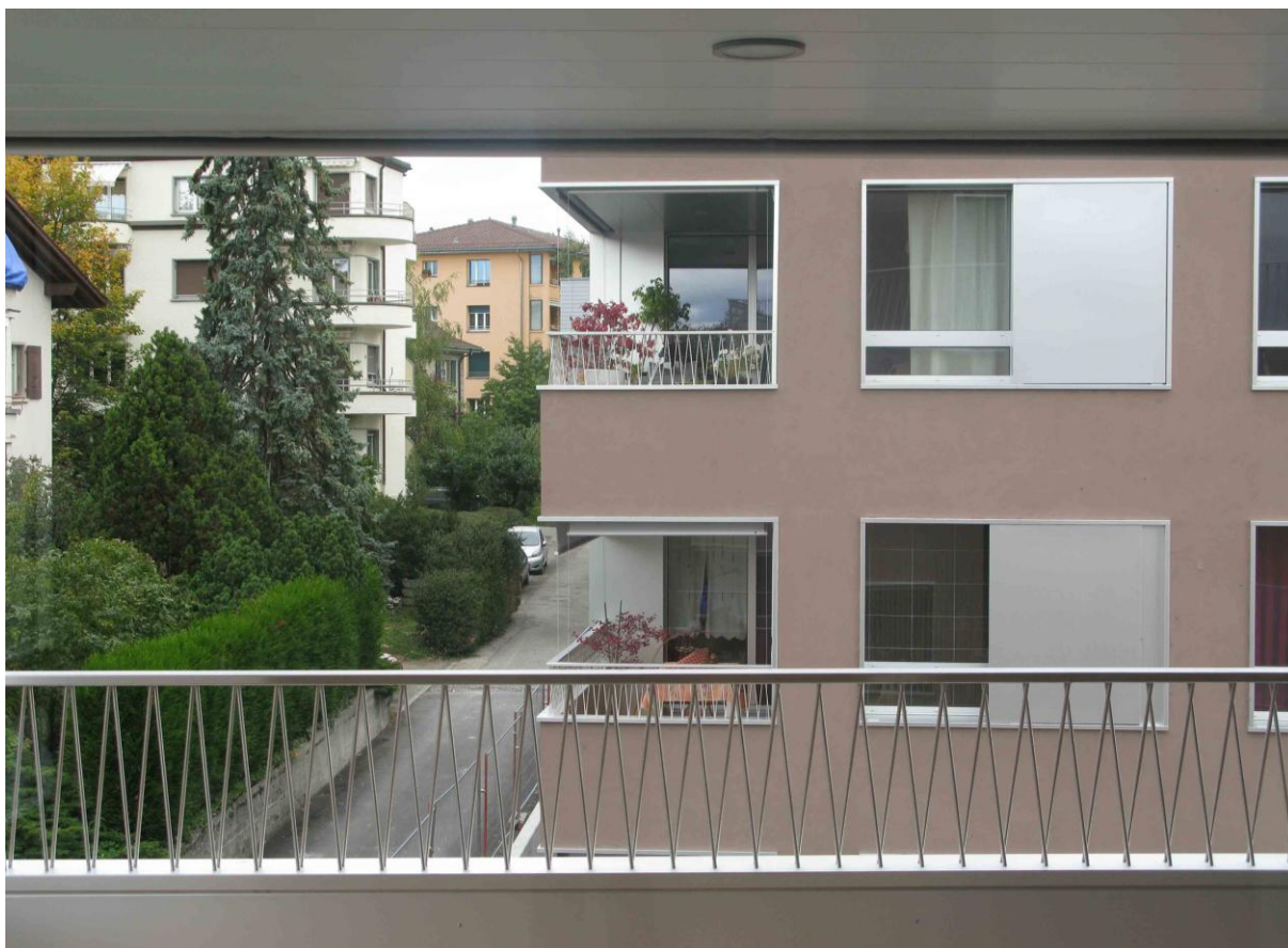
Photo 5 : Projet Victor Ruffy – Lausanne – Détail d'une loggia
