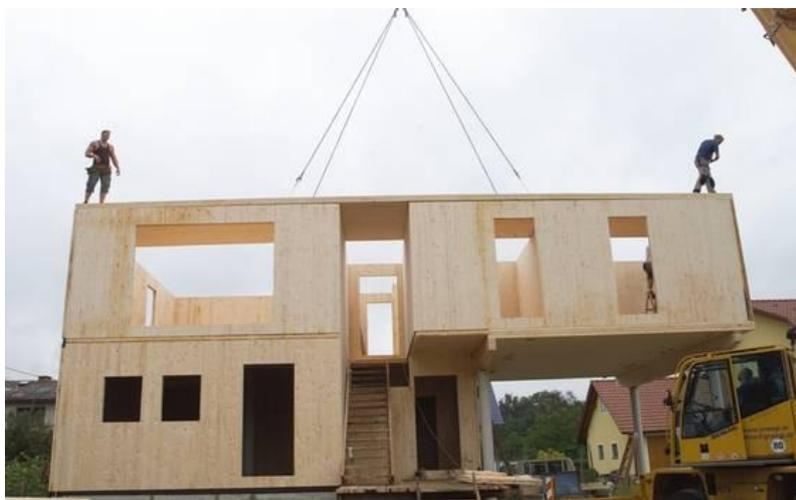
Illustration 1 : CLT utilisés en planchers et murs (extrait de [www.klh.at](http://www.klh.at))
