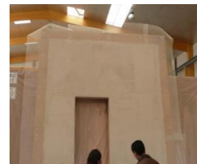
Figure 10: Panneau préfabriqué et pré-enduit en atelier / IC Bois
