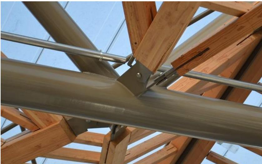
Illustration 9 : Assemblage structure bois sur structure acier.
