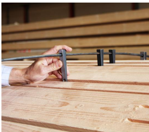
Insertion des clavettes biseautées dans les rainures ©ArtBuild reliées par les tiges filetées ©ArtBuild
