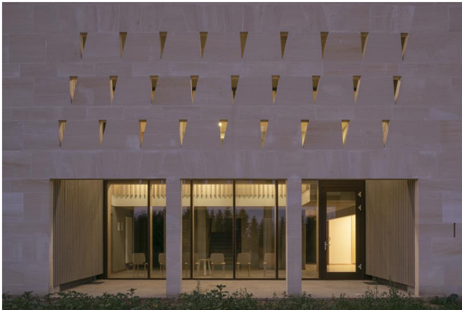
Image 4 : Détail façade sud
