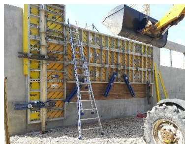
mise en œuvre du pisé
