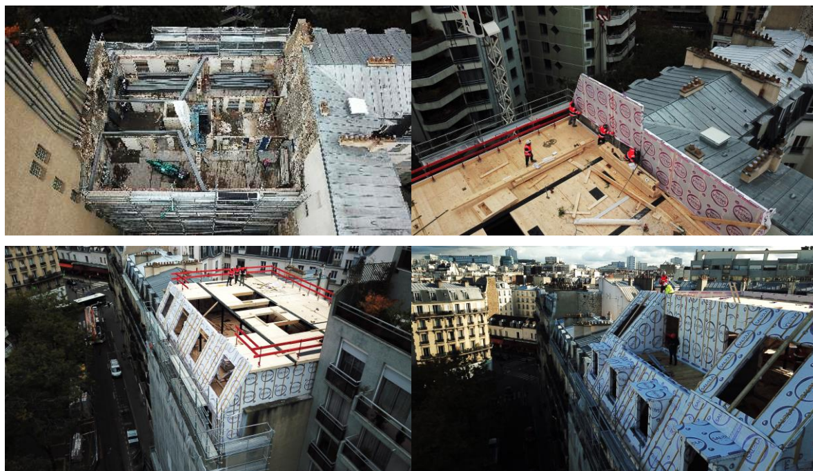
Photos du chantier (novembre 2019) - Documents © SN ERCT
