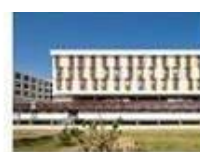
Nouvel hôpital - Orléans
