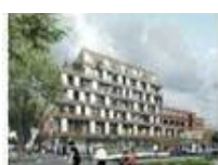
Crèche et logements - Paris
