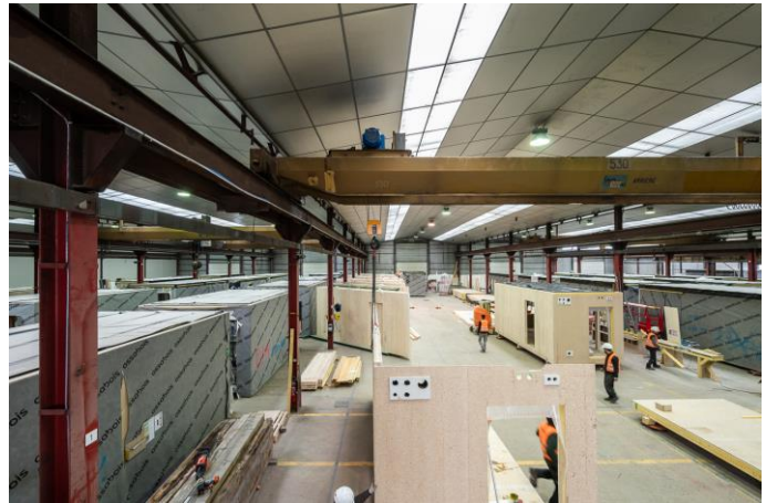
Fabrication des modules en usines
