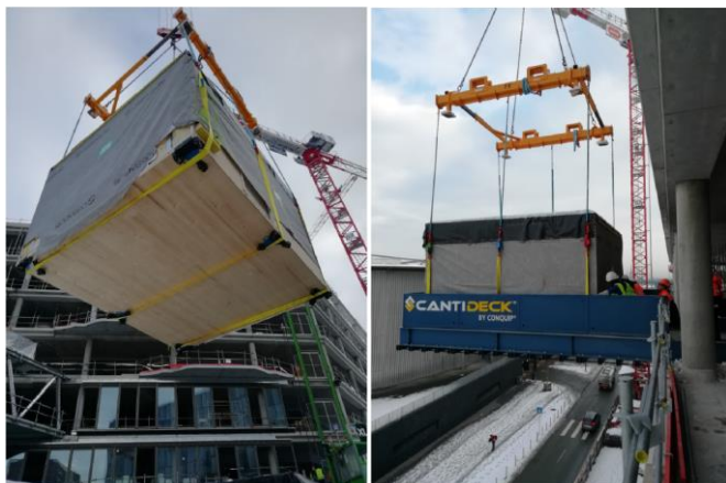
Levage et manutention des modules par la façade
