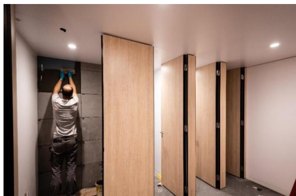
Fabrication en atelier
