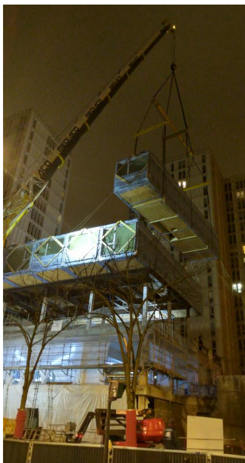
Image 8,9 et 10 : levage des modules sur site
