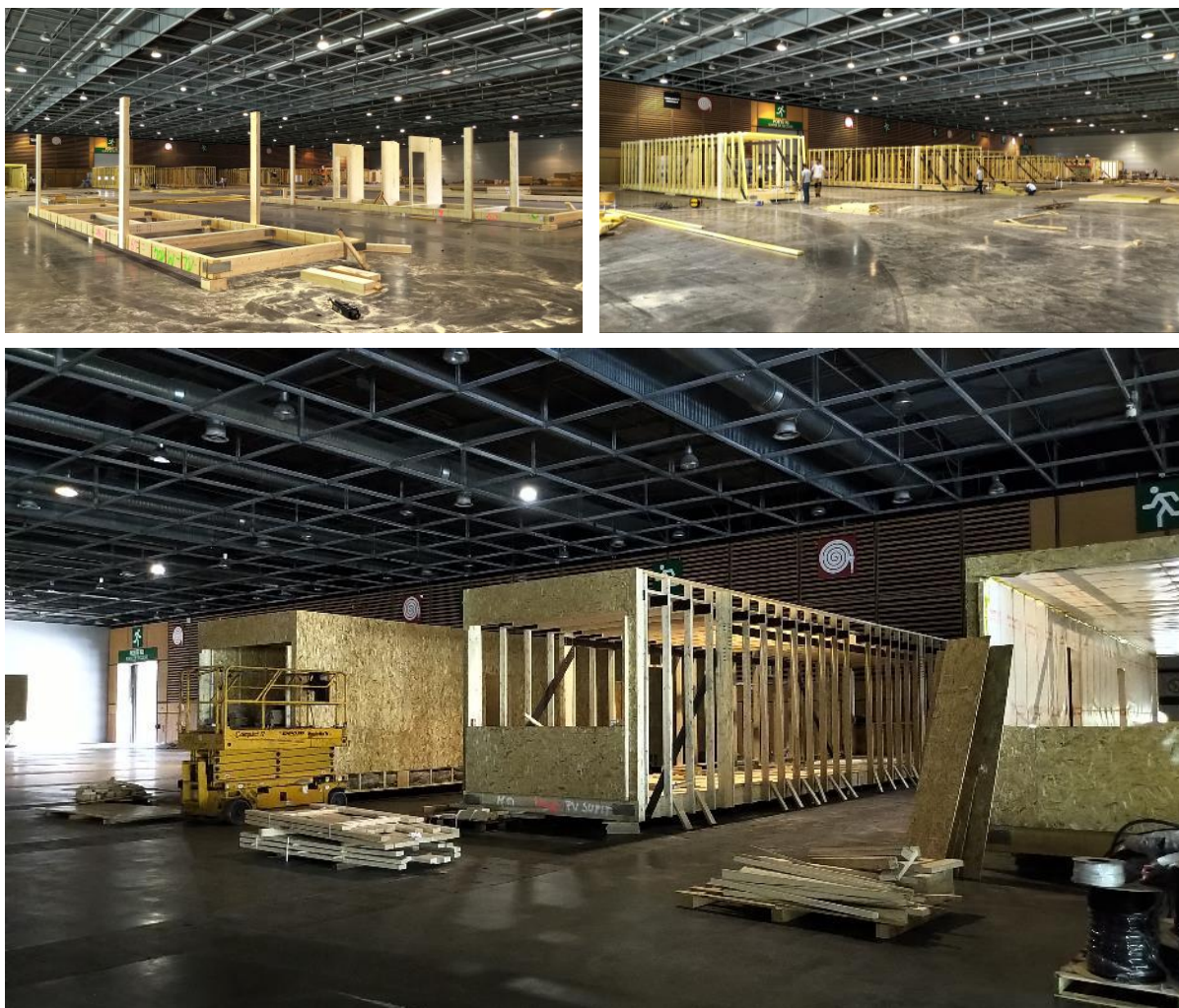
Image 5,6 et 7 : Montage des modules en atelier
