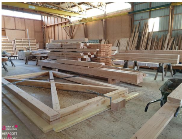
Figure 17 : Photographies de la préfabrication du bâtiment L dans l'atelier du charpentier
