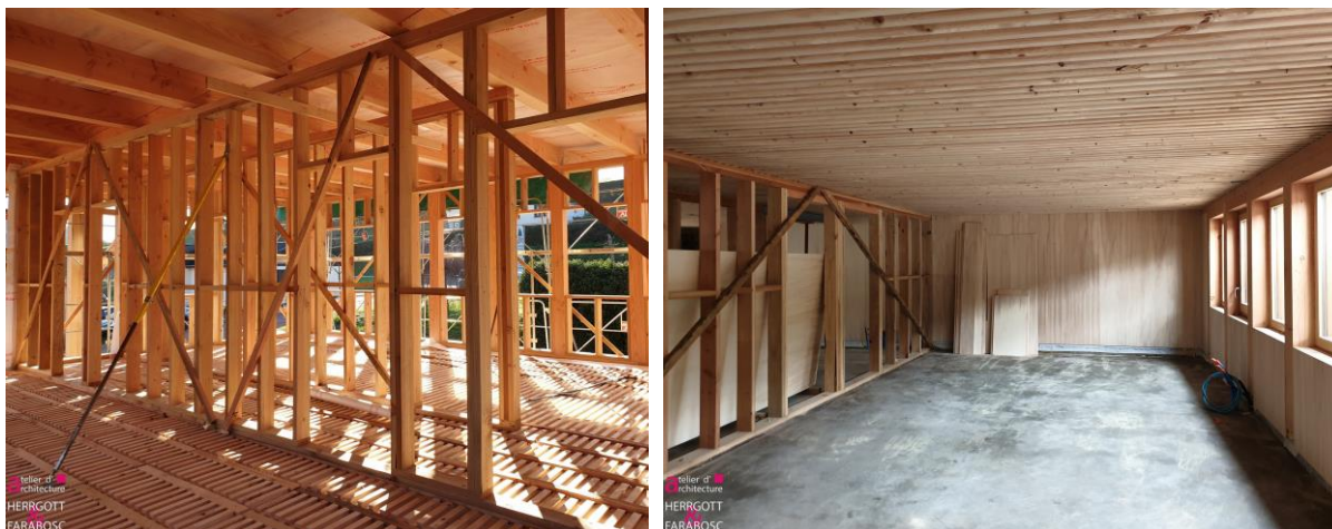
Figure 12 : Photo du R+1 et du rez-de-chaussée de l'extension pour Coforet
