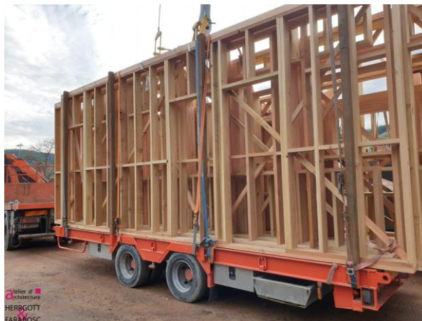
Figure 17 : Photographies de la préfabrication du bâtiment L dans l'atelier du charpentier
