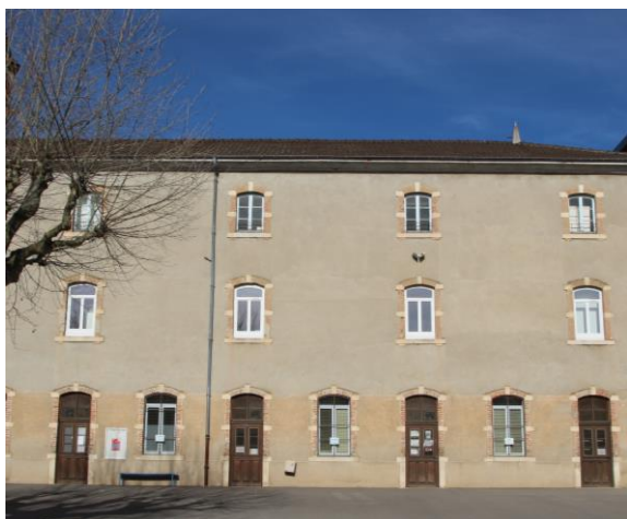
Figure 9 : Fenêtres PVC à R+1 du bâtiment B en façade sud changées avant l'intervention de l'atelier Herrgott & Farabosc
