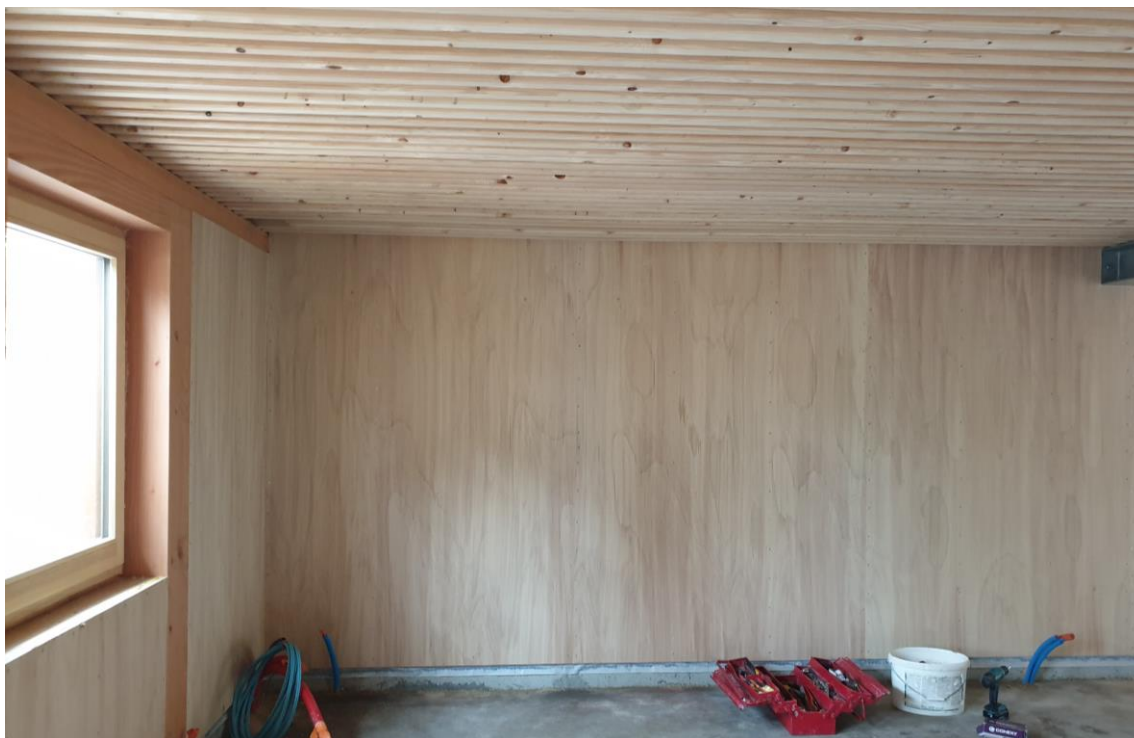
Figure 11 : Contreventement et finition intérieure en contreplaqué peuplier
