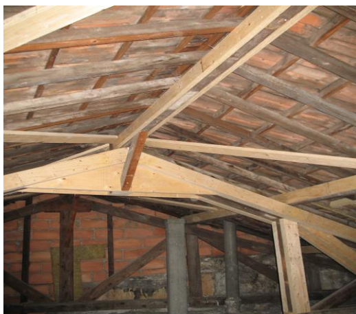
Charpente XIX e éme, renforcée et modifiée pour la réutilisation du comble
