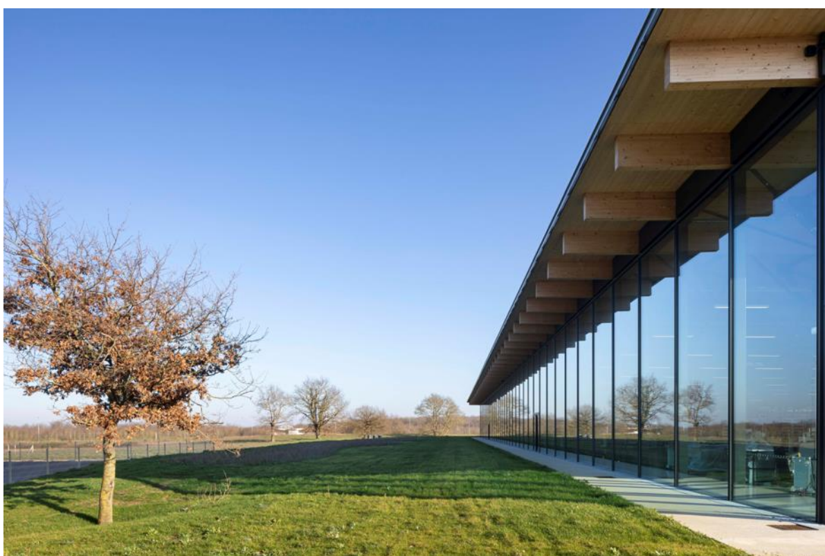
Figure 7 : Continuité intérieur-extérieur ©H. Abbadie
