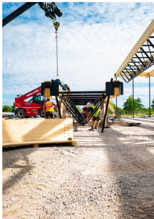
Figure 5 : Montage des poutres ©W. Berre
