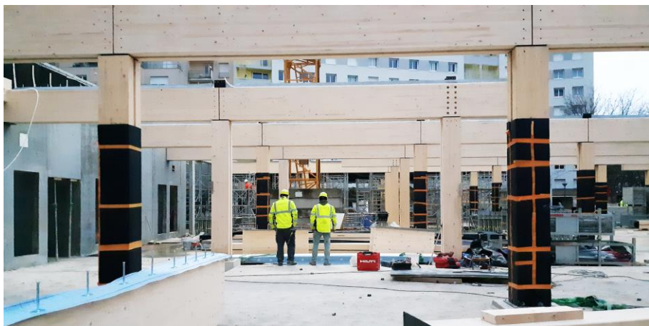
Image 2 : La pose de l’ossature poteaux-poutres en bois lamellé/collé sur le chantier – Atelier du Pont
