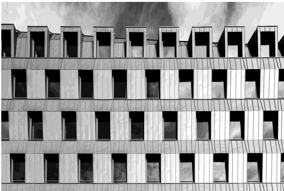
Image 9 : Principe des lucarnes préfabriquée CLT-zinc – Photo ©Tilt&shoot
