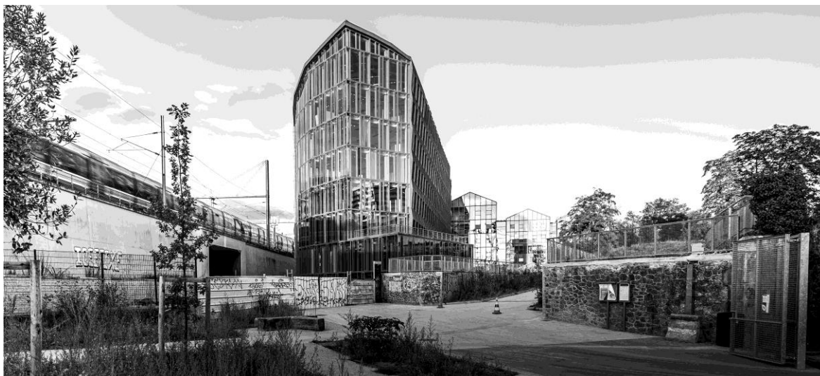
Image 4 : Entrée piétonne du site ©Nicolas Grosmond pour les 3 photos
