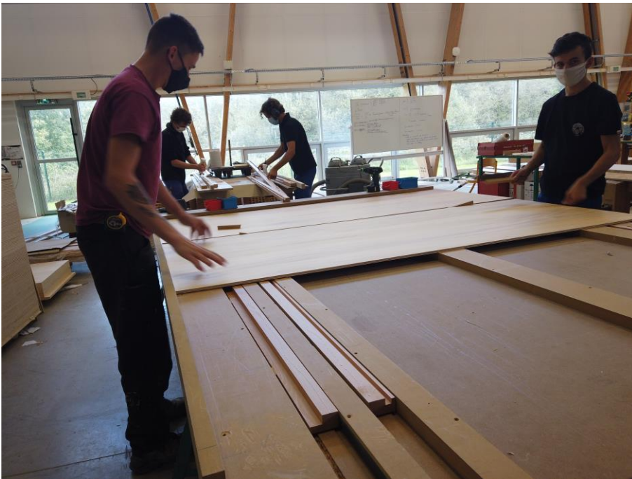
Poste de pose des panneaux de CP sur les traverses
