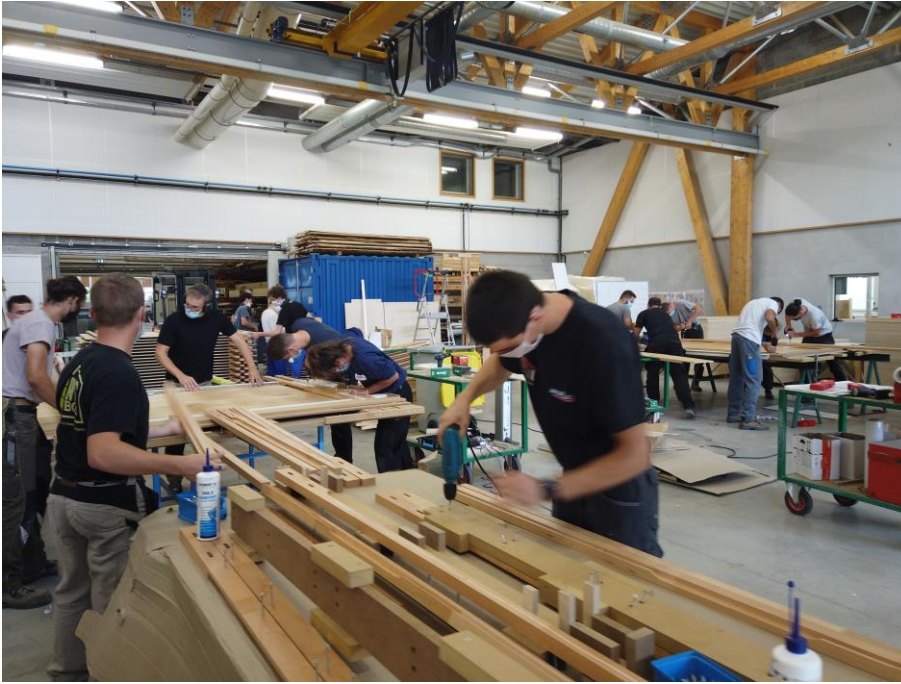
Poste d'assemblage des poteaux
