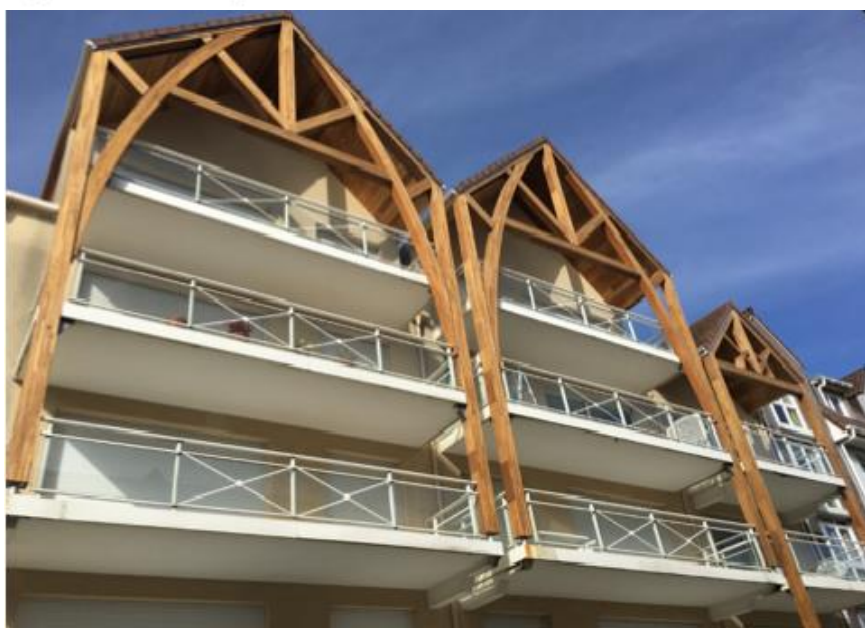
Lamellé collé IROKO + Assemblage invisibles Tiges collées procédé Résix®
