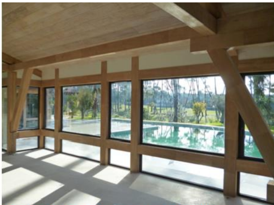
Lamellé collé chêne + Sapisol sous face chêne cérusé
