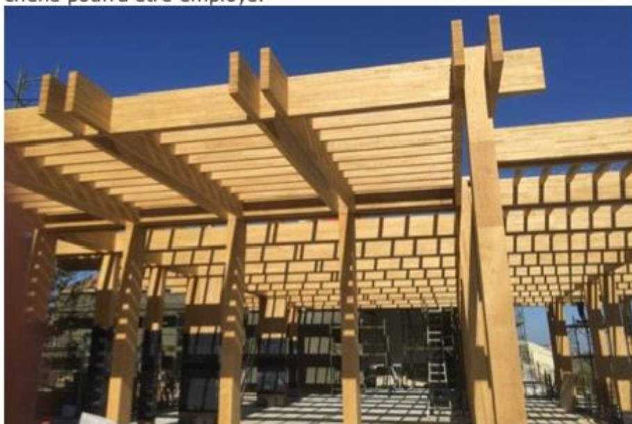
Lamellé collé Chêne + Encastrement de pied Tiges collées procédé Résix®
