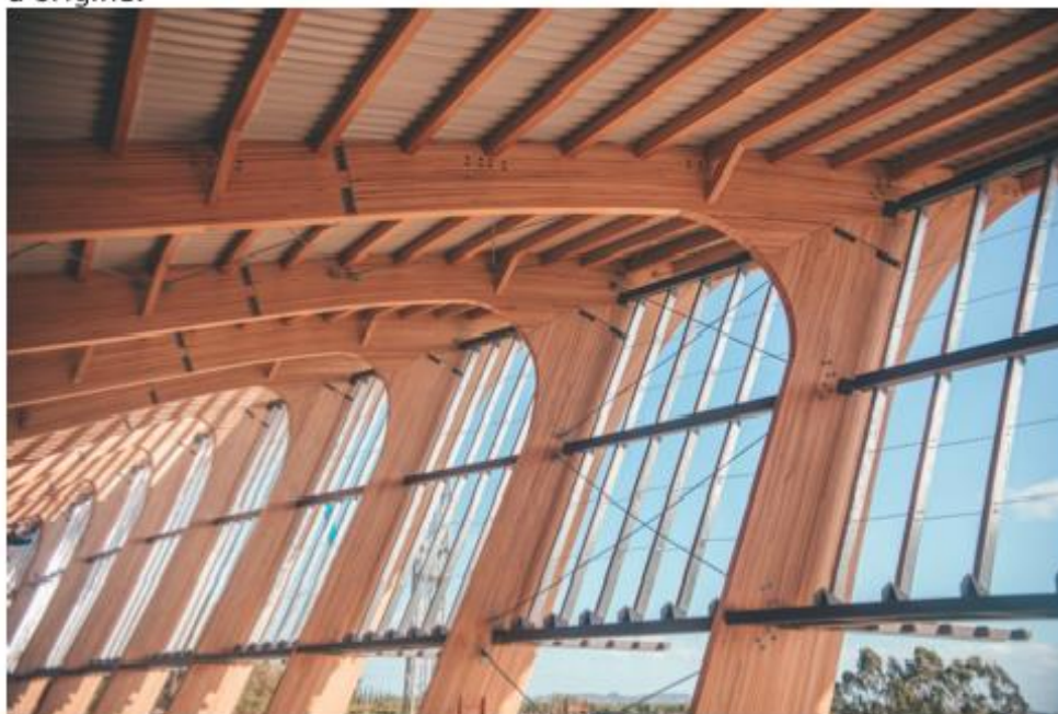
Lamellé collé Eucalyptus Red Grandis + Assemblage Tiges collées procédé Résix®
