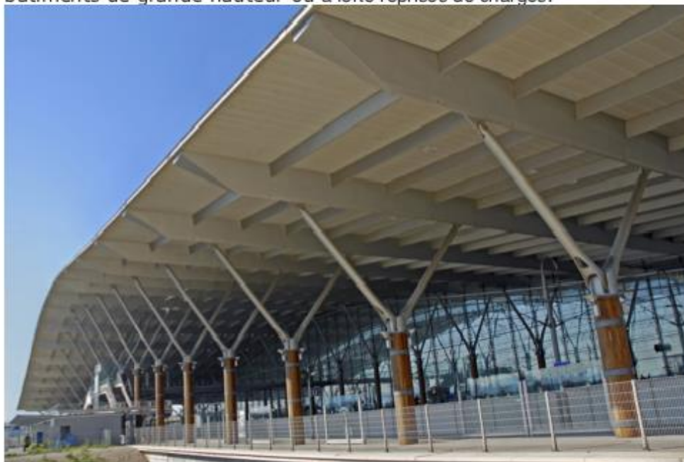
Lamellé collé IROKO + Assemblage invisibles Tiges collées procédé Résix®
