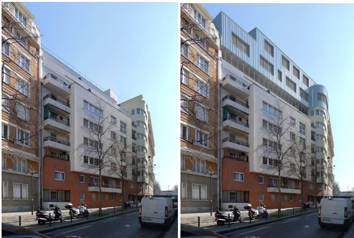
L'immeuble existant sur rue Claude Decaen à gauche, le projet de surélévation à droite. DR
