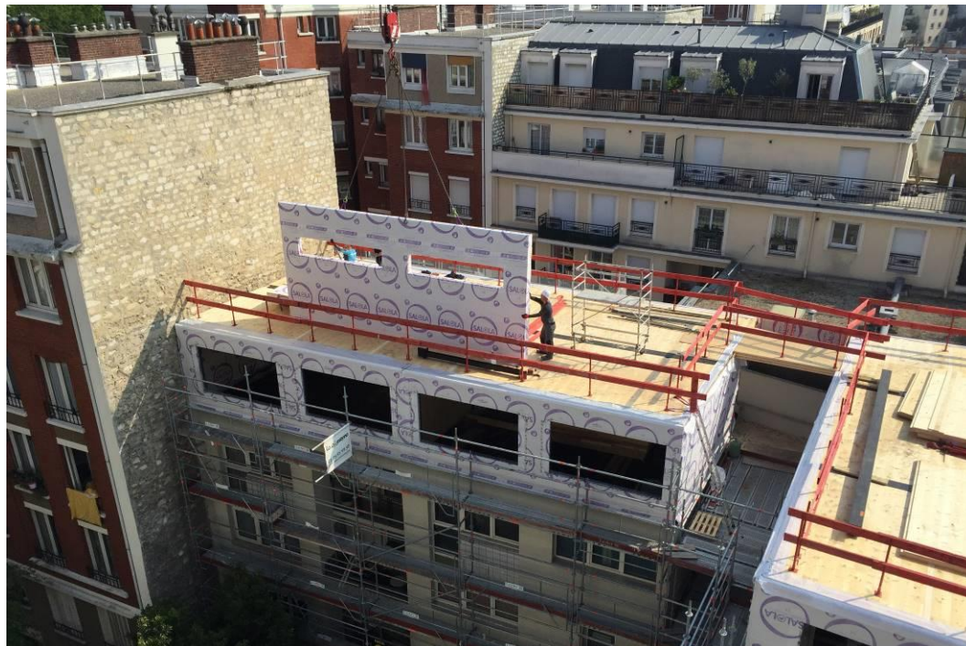
Le grutage de la surélévation du bâtiment B en cours. DR
