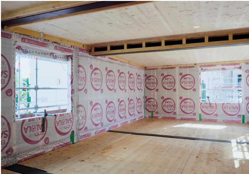
La structure de la surélévation avant doublages. Photo Coline Bublex
