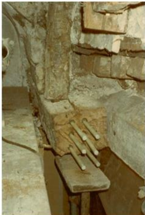
Sté BEPOX - Assemblages en rénovation
