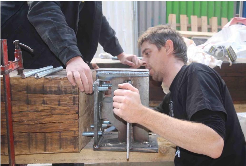
Assemblages collés avant levage.
