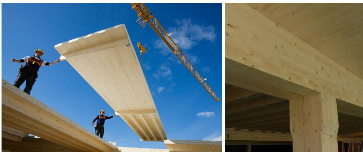
Figure 10 : montage des panneaux bois massifs au faîtage et ajustement géométrique des poteaux-poutre lamellé-collé (© Martinsson; © AIX)
