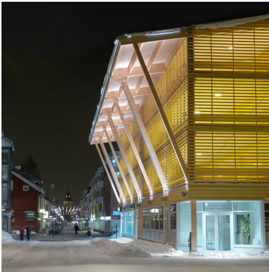
Figure 2 : Un parking est une structure publique dont l'utilisation – donc illumination - est continue. Cette qualité utilisée ici comme phare d'orientation urbaine . (© AIX)
