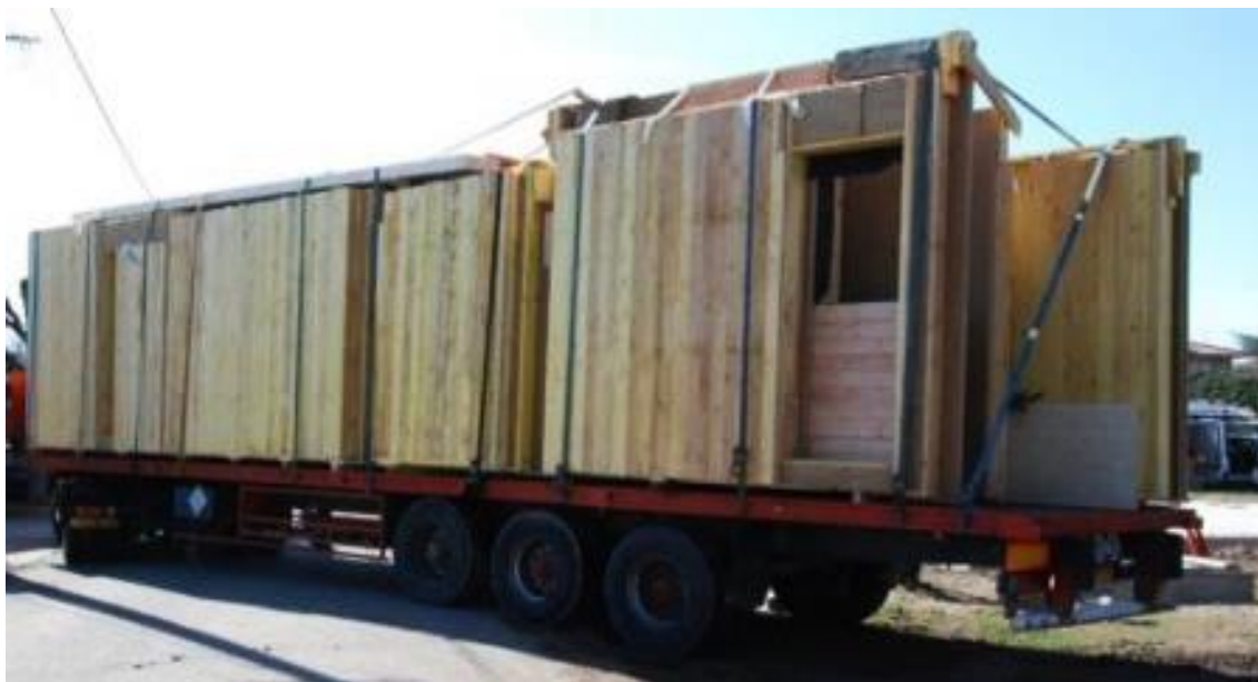
Transport des murs préfabriqués de la Maison des Aînés de Montbrison
