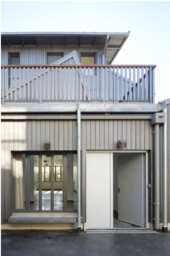
Figure 5 : depuis la rue intérieure vers un atelier.
