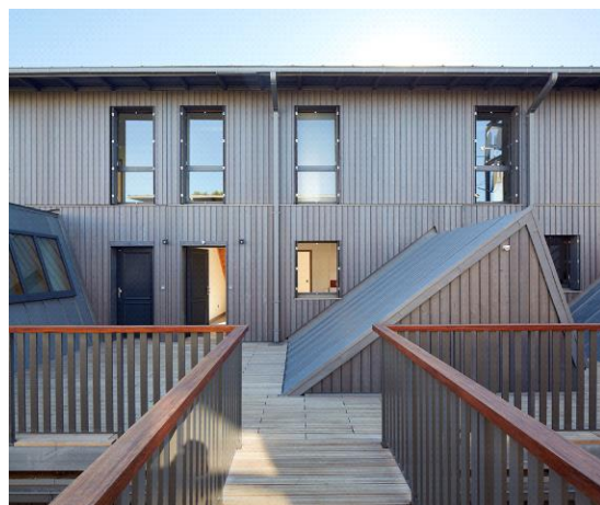
Figure 10 : étage, les coursives, vers l'Ouest
