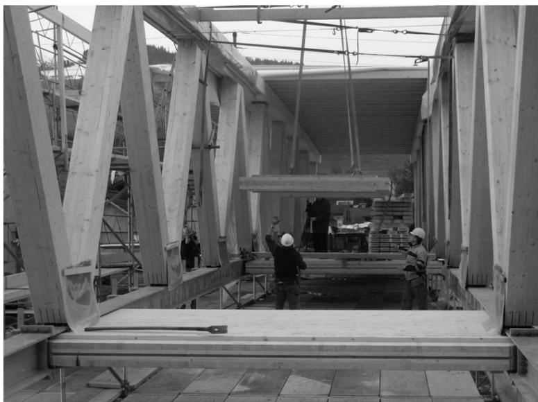
Figure 4 : pont routier en lamellé-collé et PMC épicéa industriel
