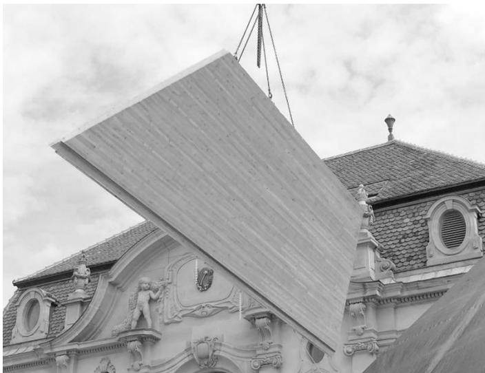
Figure 7 : toiture PMC, sous-face mélèze (musée Unterlinden)
