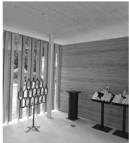
Figure 8 : la toiture PMC en épicéa apparent contraste avec les murs en mélèze (oratoire à Paray-le-Monial)
