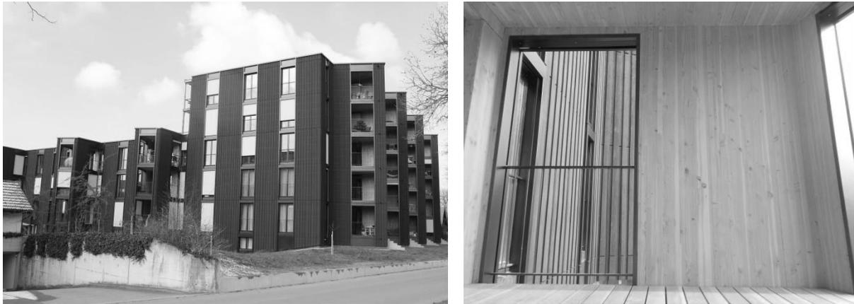
Figure 6 : terrasses couvertes en murs et planchers PMC douglas visible, jusqu'à 5 étages. L'utilisation de lamelles douglas en quartier et faux-quartier confère aux panneaux une meilleure durabilité et un bon comportement hygrométrique en extérieur couvert
