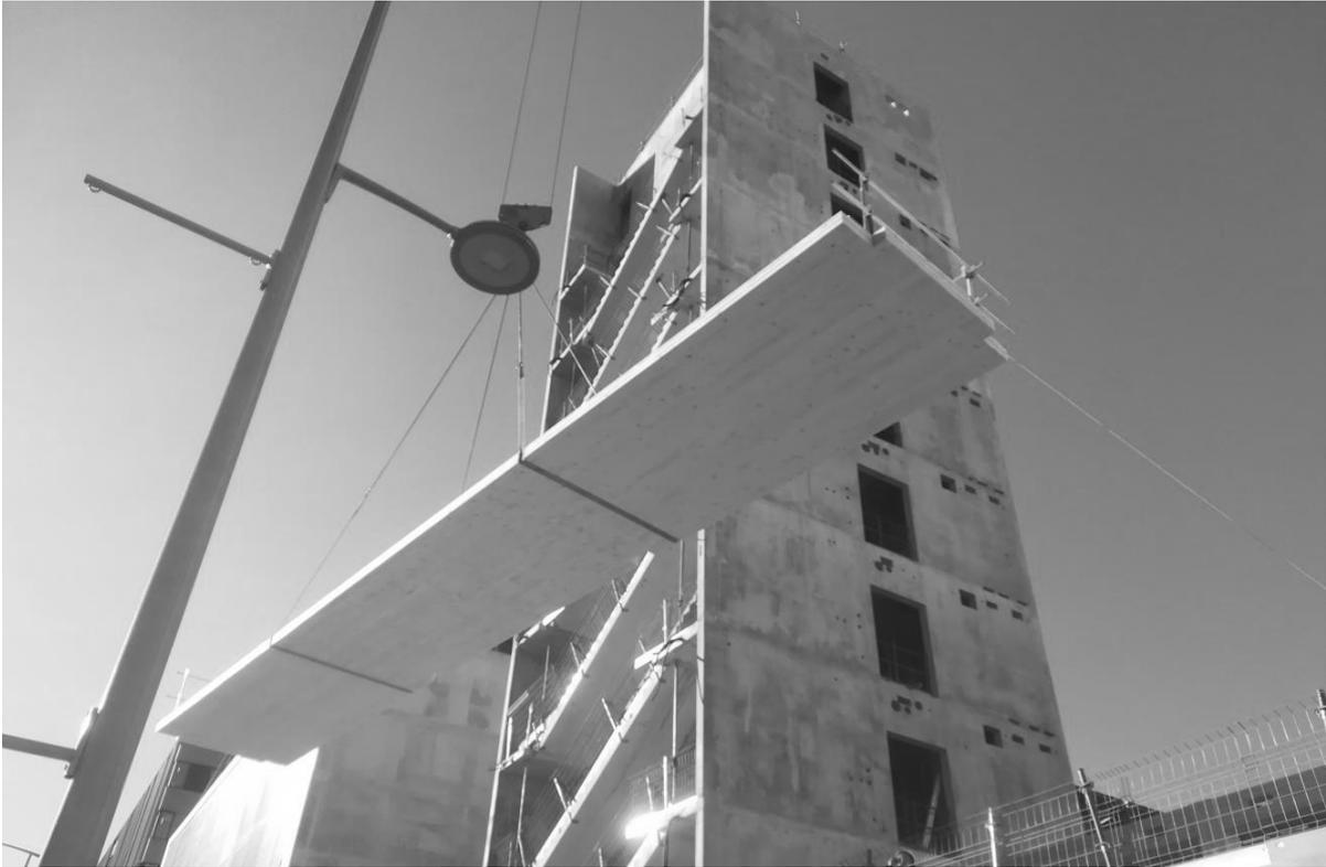
Figure 11 : les planchers du Palazzo Méridia, de dimensions 2,6 x 16,9 m, visibles en sous-face, sont produits en bois français
