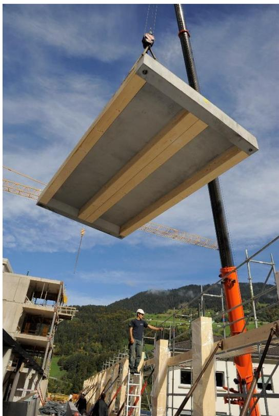
Les éléments de plancher sont constitués de poutres BLC associées à 8 cm de chape armée
