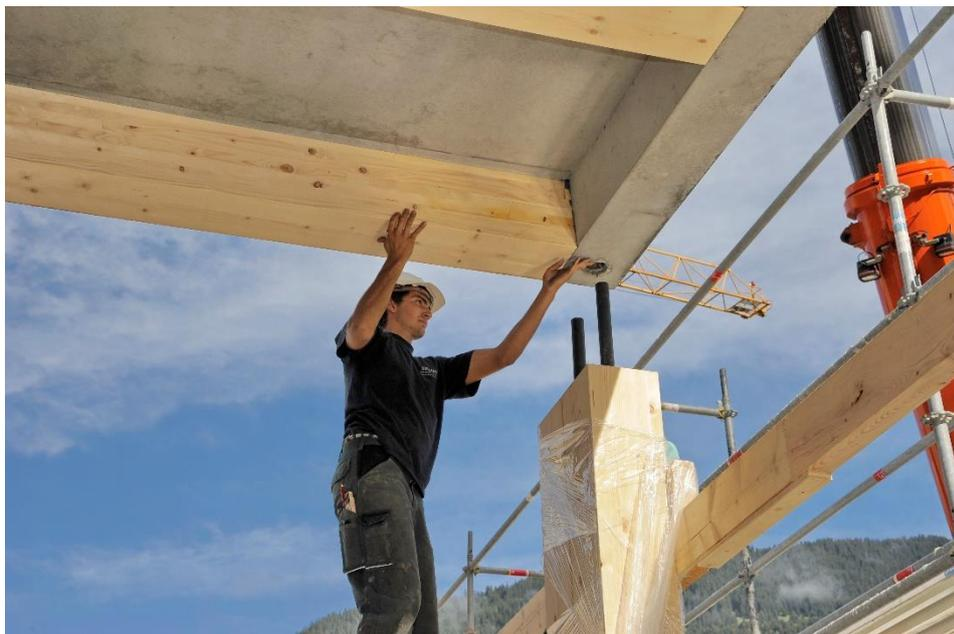
Les poteaux sont solidarisés avec les éléments de plancher mixtes par simple emboîtement de goujons. Ce principe permet de garantir l'alignement vertical et garantit une montée en hauteur rapide et la tenue des plannings.
