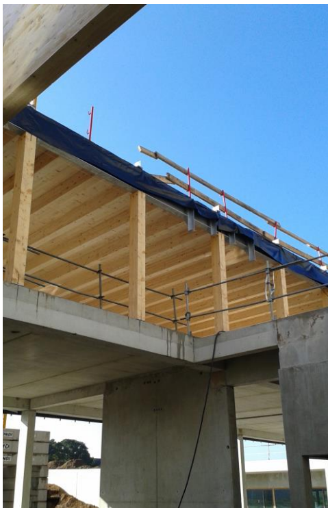
Illustration 5 : Vue du plancher nervuré à partir du rez-de-chaussée ©Julien Lanoo
