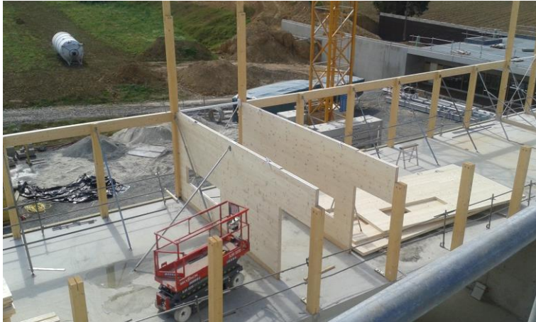
Illustration 3 : Mise en place des voiles en CLT autour des « serres » en R+1 ©Julien Lanoo
