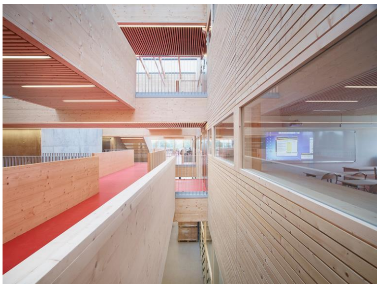
Illustration 11 : Dialogue des habillages et des sous-faces, des parois en BLC et du voile, en direction des salles de classes sud à parois légères habillée de lames de bois. ©Julien Lanoo
