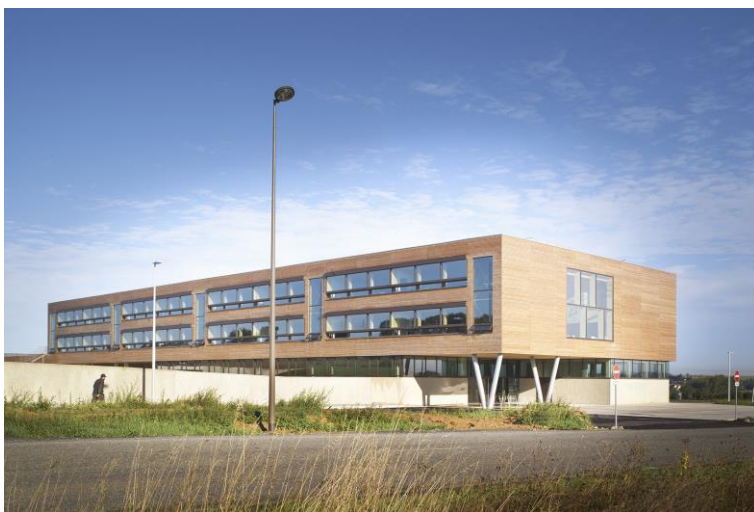
Illustration 7 : Le bâtiment achevé, avec l'entrée principale. Un bâtiment compact de volumétrie simple, tout en bois et comme posé sur un socle en béton. ©Julien Lanoo
