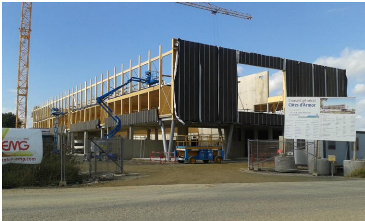
Illustration 6 : Le bâtiment principal en cours de construction ©Julien Lanoo
