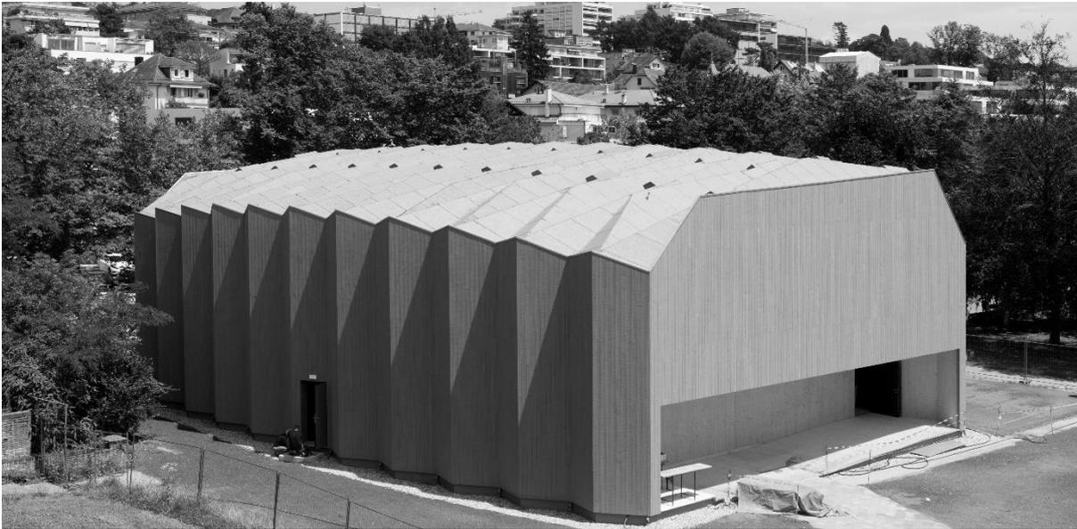
Figure 1 : Pavillon du Théâtre de Vidy à Lausanne : une structure double nappe entièrement en bois d'une portée de 22m
