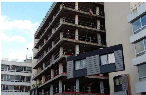
Mise en œuvre des premiers panneaux de façade
