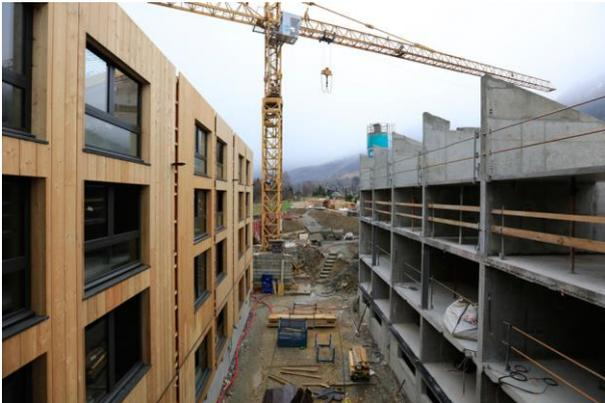
Illustration 6 : Des panneaux isolants en ossature bois recouvrent la structure béton pour créer les façades.
