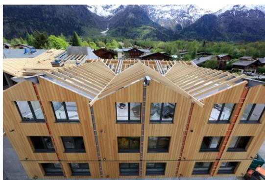
Illustration 9 : Les fenêtres sont en carrelés trois plis de pin, peints en noir. La charpente est réalisée en mélèze du Vercors.
