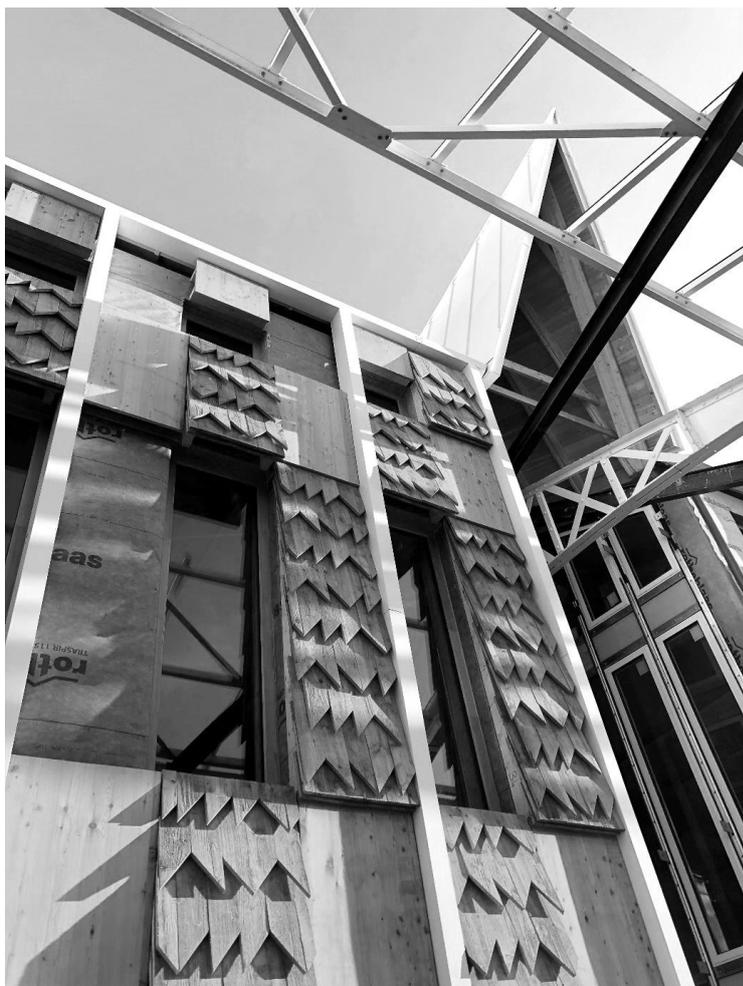
Figure 2 : Bardage bois en bardeaux et panneaux 3 plis mélèze
