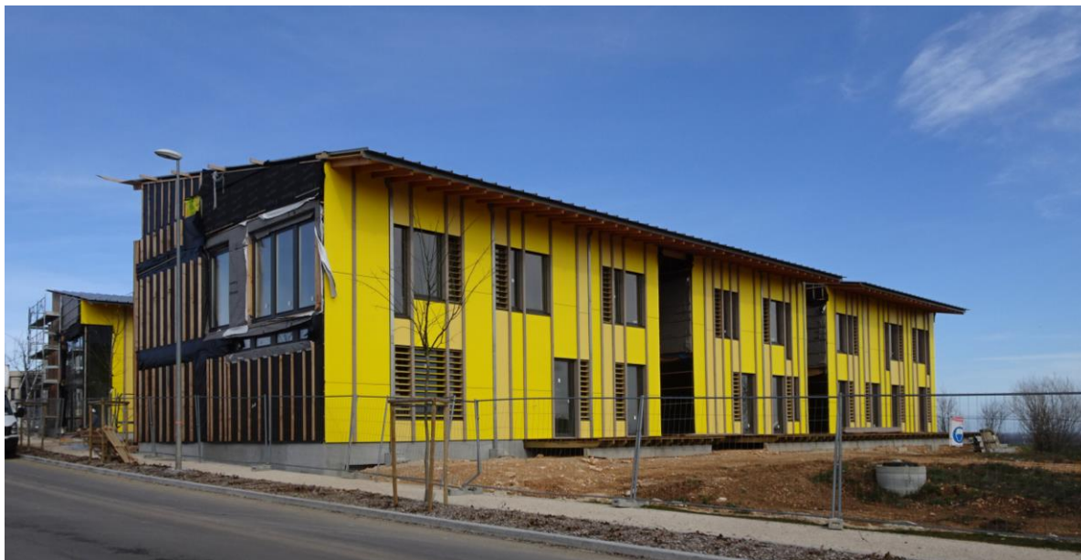
Façade Sud : des panneaux bois résine en camaïeu de jaune vif, calepinés et rythmés de verticales bois
