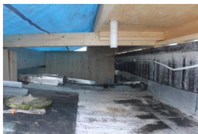
Plénum technique crée et sous-face de la passerelle bois
