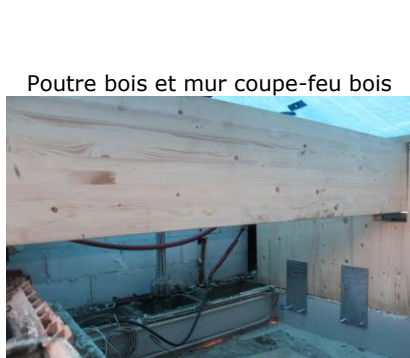
Plénum technique crée et sous-face de la passerelle bois
