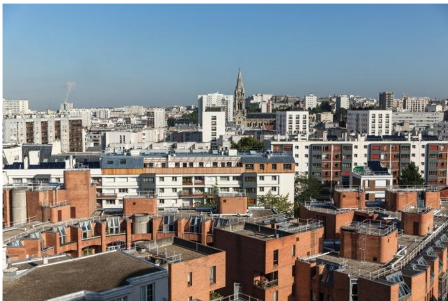
6 logements en surélévation à Paris (75), Lair & Roynette, ©Alexis Toureau
