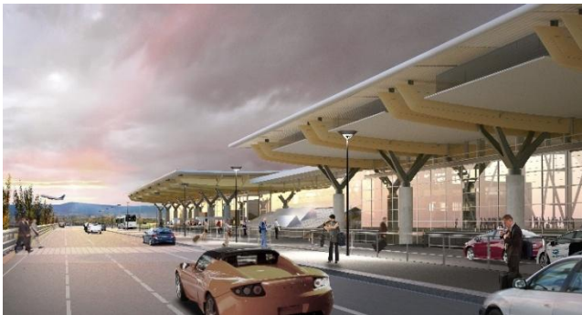
Illustration 1 : Terminal 1 et Terminal 2 (» SentralbygningVest «)
