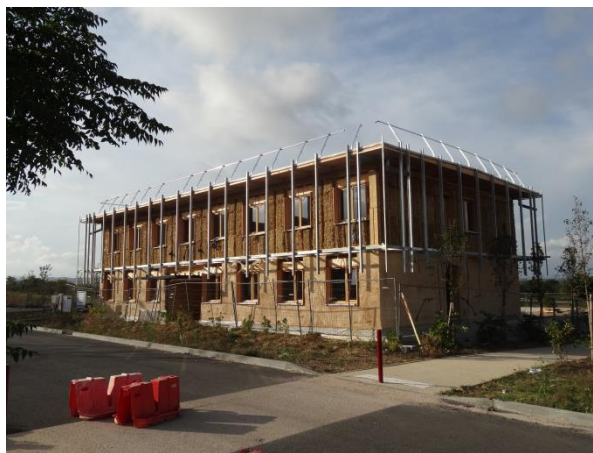
Figure 9 et 10 : Murs ossature bois montés et remplissage en bottes de paille enduites
