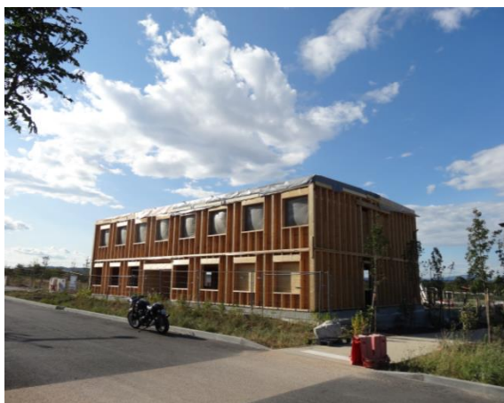
Figure 9 et 10 : Murs ossature bois montés et remplissage en bottes de paille enduites
