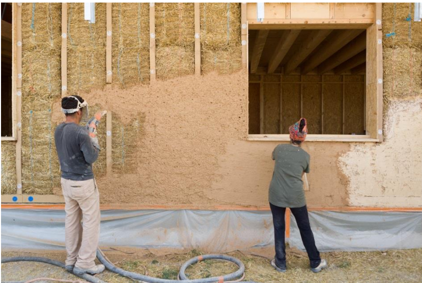
Figure 7 : Mise en œuvre de l'enduit terre extérieur (Photo Steven Morlier pour IZUBA énergies)
