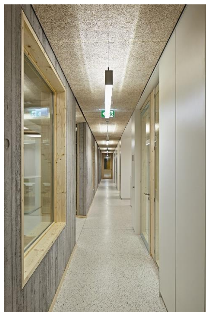
Lisibilité des matériaux et du principe constructif, à l'exemple des plateaux de bureaux; planchers et poteaux en bois, noyau béton à coffrage architectural et chape hydraulique lissée.
