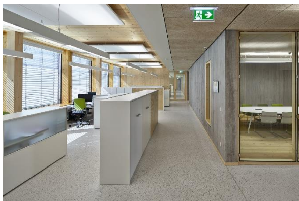
Lisibilité des matériaux et du principe constructif, à l'exemple des plateaux de bureaux; planchers et poteaux en bois, noyau béton à coffrage architectural et chape hydraulique lissée.
