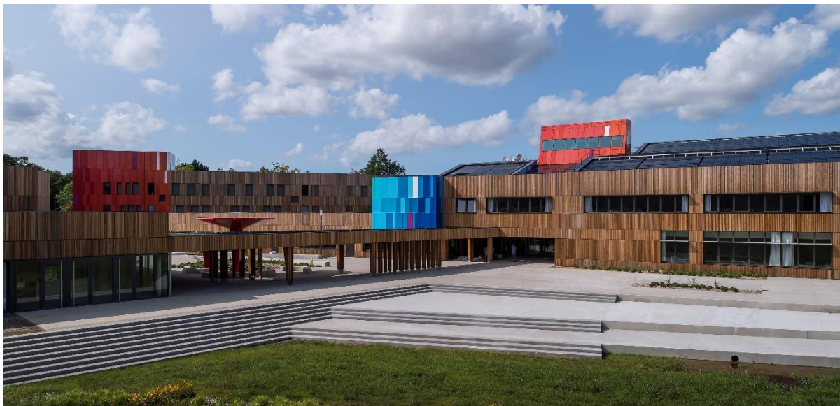
Figure 3 : Vue extérieure du Lycée © Patrick Miara
