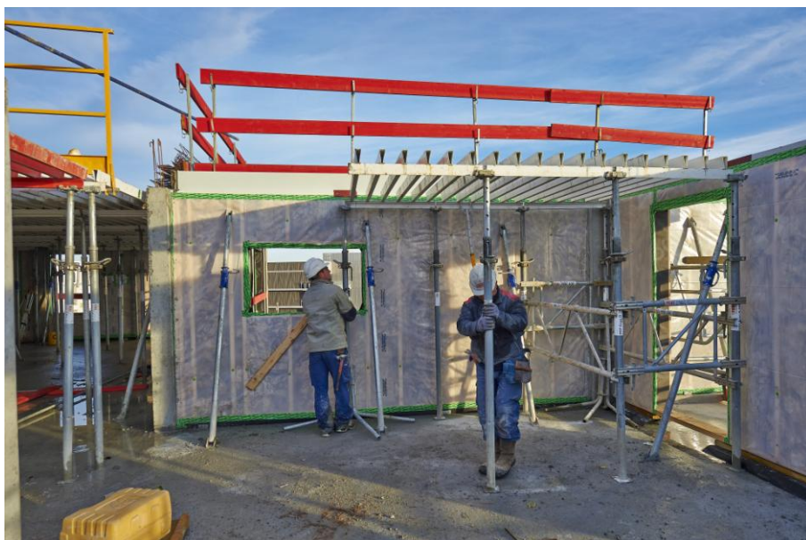
Image 10 : mise en place des murs bois coffrants
