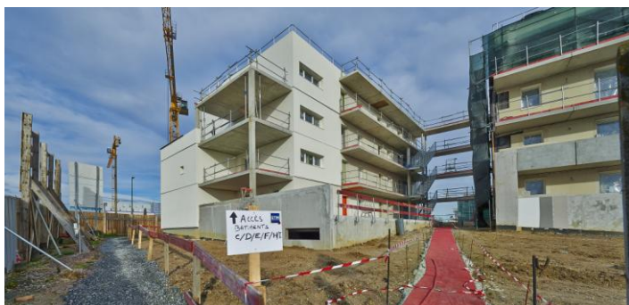
Image 11 : bâtiment A avec finition enduit sur façade bois
