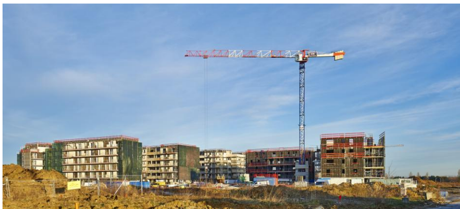
Image 9 : vue générale du projet
