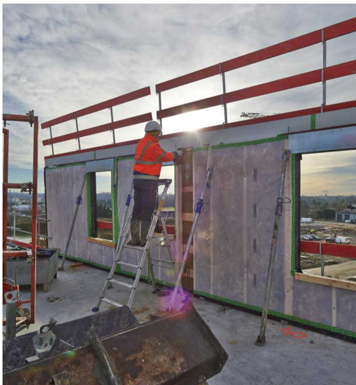
Image 12 : mise en place des murs bois coffrants
