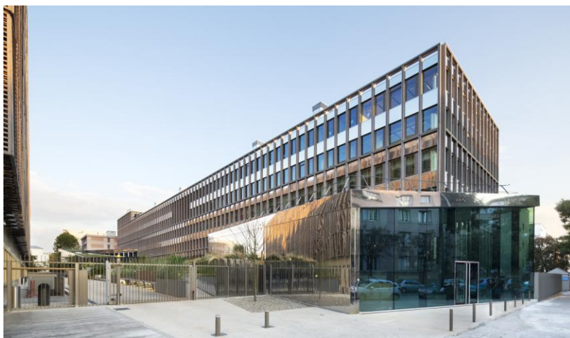
Illustration 5 : avenue Pasteur façade nord ©Michel Denancé
