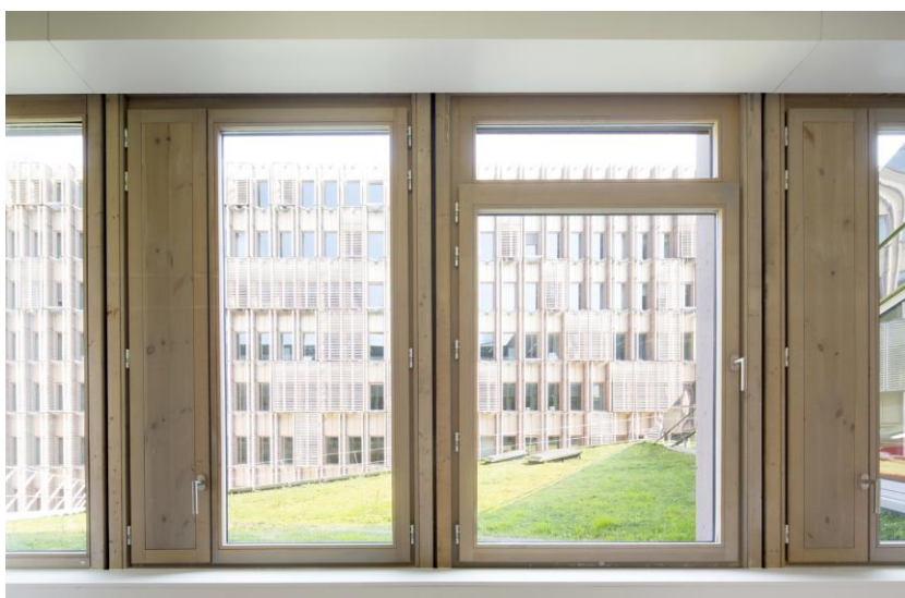
Illustration 20 : intérieur bureau volet ventilation ©Michel Denancé
