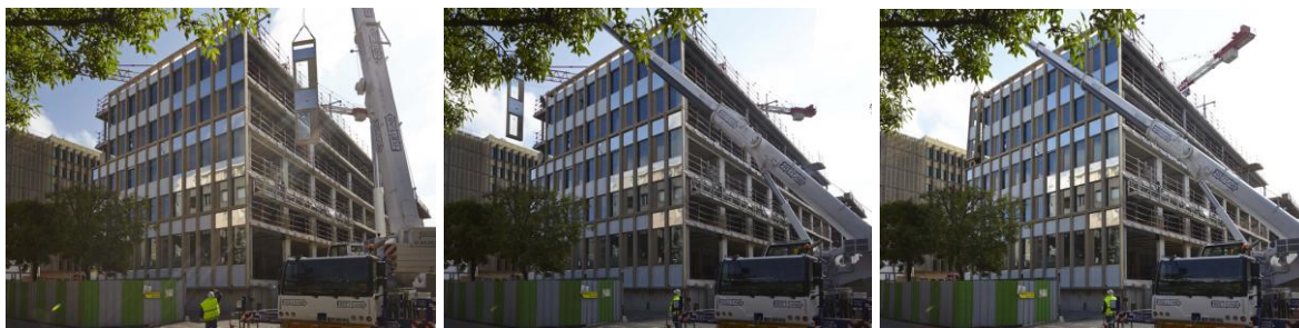
Illustration 15 : montage modules façade ©Frédéric Delangle
