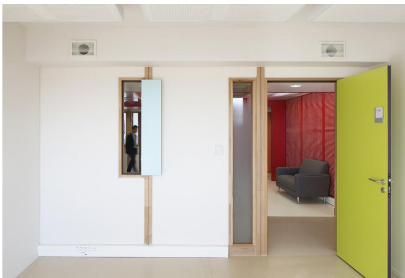
Illustration 19 : intérieur bureau volet ventilation ©Michel Denancé
