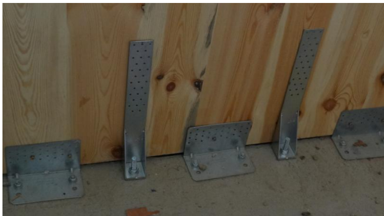
Illustration 12 : Raccordement des parois au socle en béton
