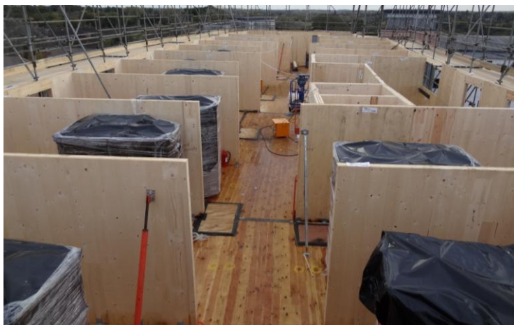
Illustration 7 : Modules de salles de bains durant le montage ©EURBAN Limited
