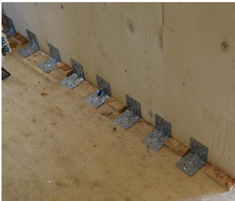
Illustration 11 : Raccordement de la paroi au plancher bois
