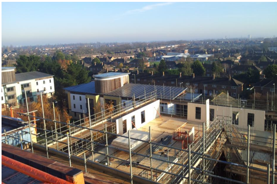
Abbildung 15 : Photo durant montage 11.12.2013 ©EURBAN Limited
