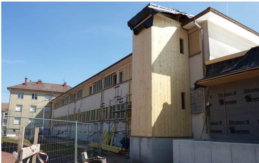
Image 5 : Volume de la cage d'ascenseur en KLH façade Nord
