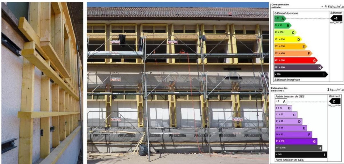
Images 8-9 : Ossatures croisées sur murs existants,
