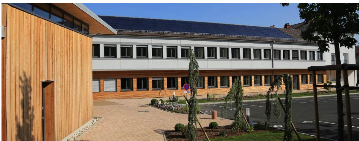
Image 11 : Vue du bâtiment existant avec les panneaux photovoltaïques en toiture
