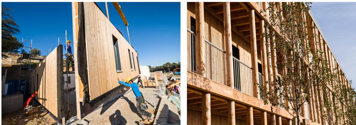
Chaque mur est composé d'un panneau plein porteur en Epicéa, d'une couche d'isolant en fibre bois, d'une couche de pare-pluie, de contrelattes noires, et de lattes apparentes en Mélèze, le tout pour une épaisseur de 30 cm.
