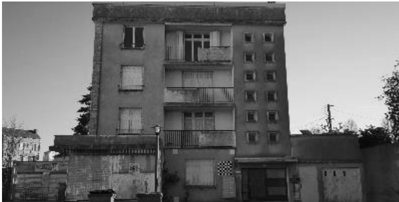
Image 1 : Façade principale Sud du bâtiment
