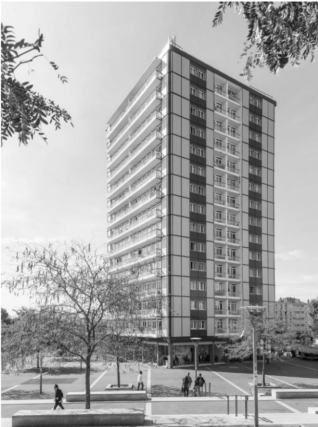
Figure 5 : La tour Ravel Gare après travaux, septembre 2019. DR
