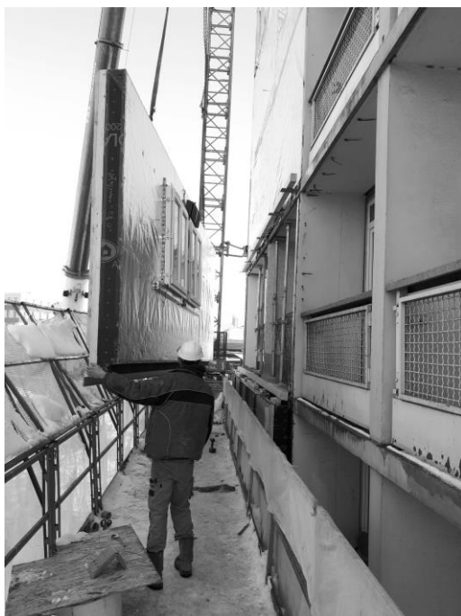
Figure 3 : Pose de panneaux de façade, février 2018. DR
