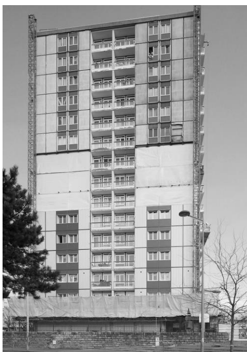
Figure 4 : La pose de la nouvelle façade a été effectuée de bas en haut. On voit ainsi sur la photo 5 étages achevés, puis 3 étages désamiantés et déposés, et enfin 6 étages existants. DR
